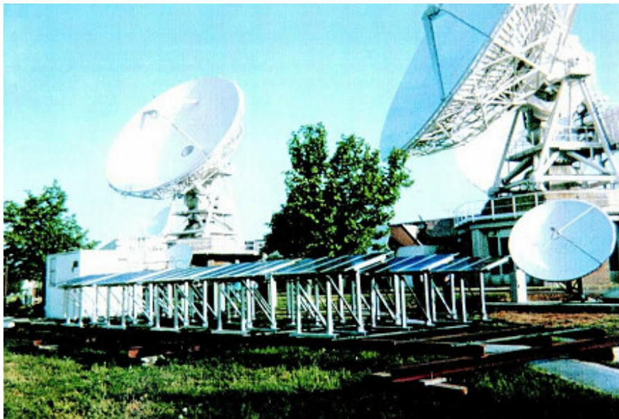
Station de relais France Télécom, Guyane
